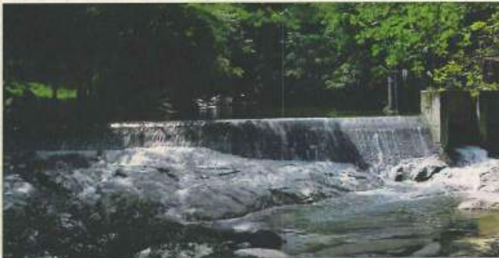
Ilustración 9. Captación río Manzanares
