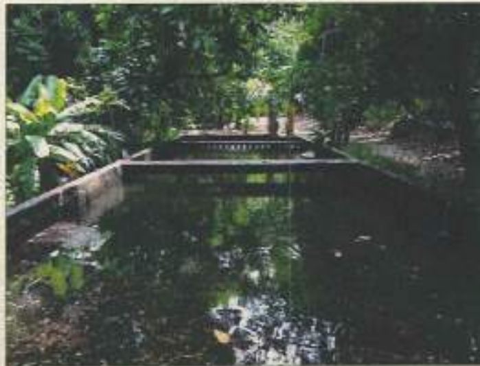
Ilustración 13. Desarenador 1 – río Manzanares.
