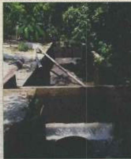
Ilustración 14. Desarenador 2 – río Manzanares.
