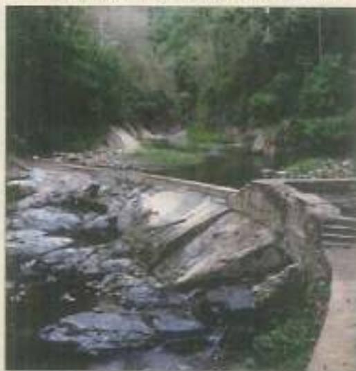
Ilustración 10. Captación río Piedras.
