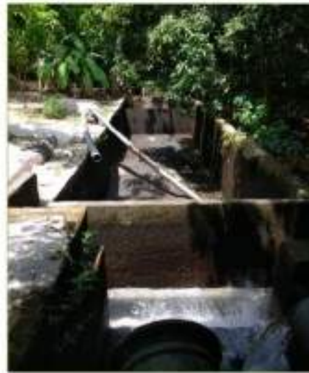
Ilustración 14. Desarenador 2 – río Manzanares.
