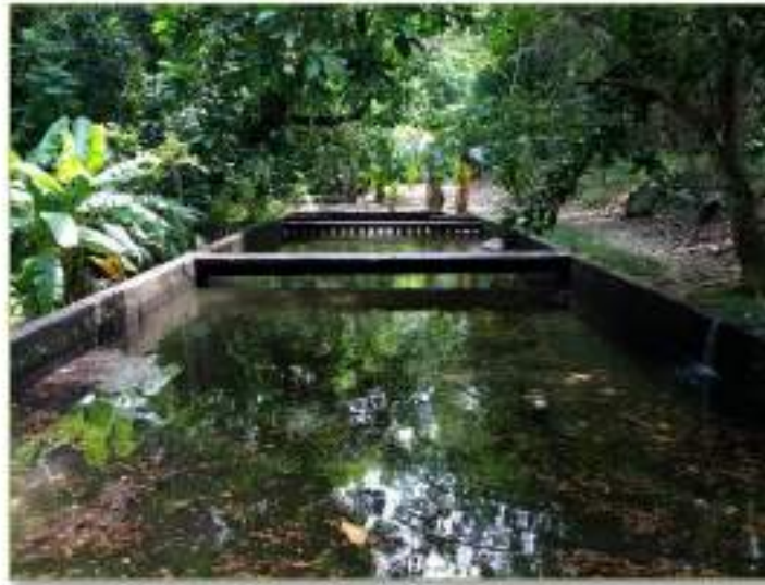
Ilustración 13. Desarenador 1 – río Manzanares.
